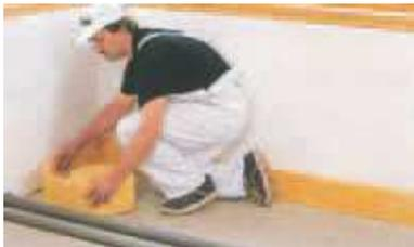
Z. B. Feuchträume oder Bodenplatten erfordern eine Dampfsperre. Diese zuerst auslegen und im Bereich der Wand hochziehen. Randstreifen an der Wand, die zwei bis drei Zentimeter über den Fertigfußboden hinausragen, vermeiden Schallbrücken.
